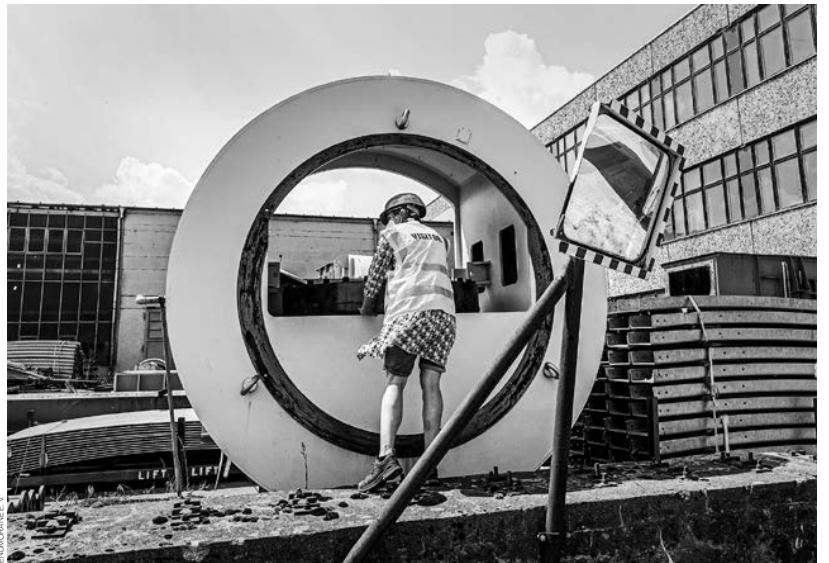
Wir bauen eine Arche: Vorbereitungsarbeiten in Beeskow
