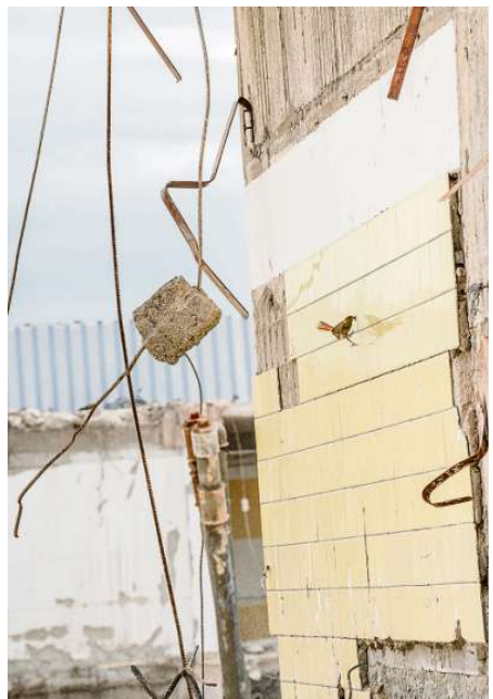
Unbehaust. Die FH Potsdam muss einem historisierenden Neubau Platz machen.
